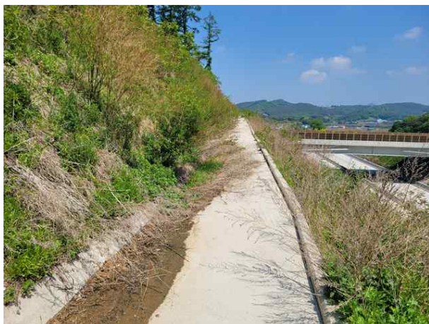
소단 배수로 전경
