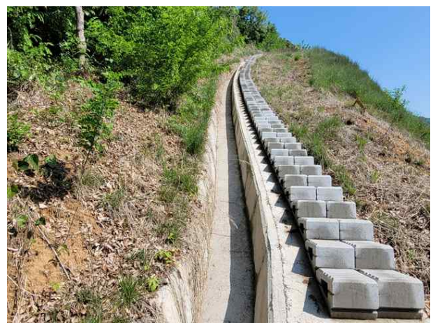
산마루측구, 점검계단 전경
