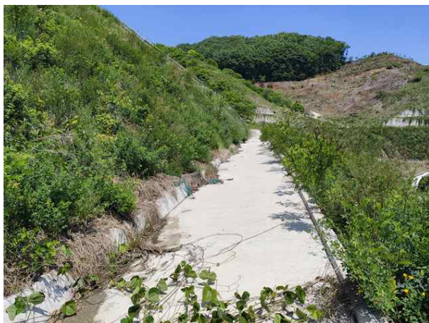
소단 배수로 전경
