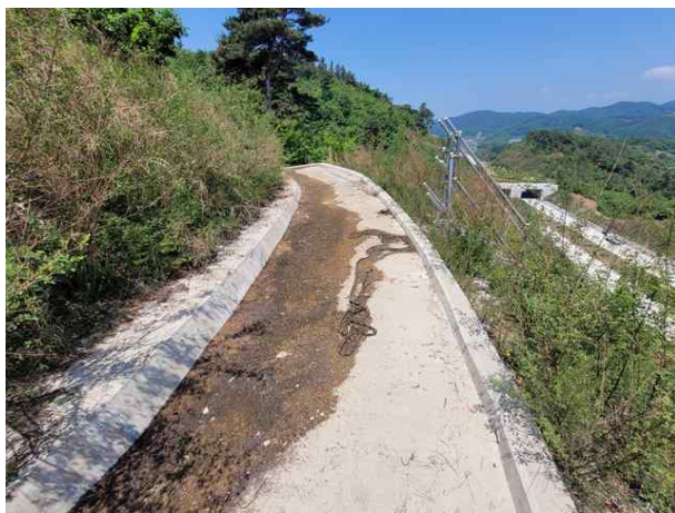
소단 배수로 전경
