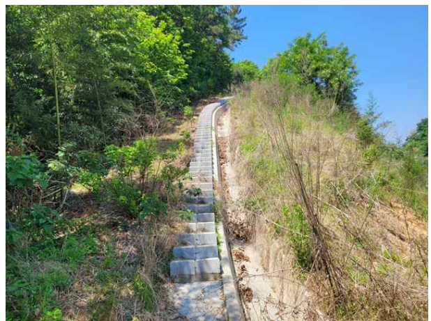
산마루측구, 점검계단 전경
