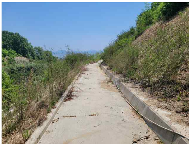
소단 배수로 전경
