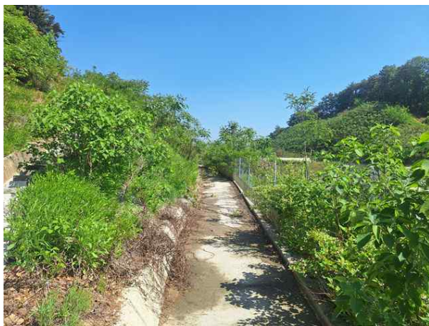
소단 배수로 전경
