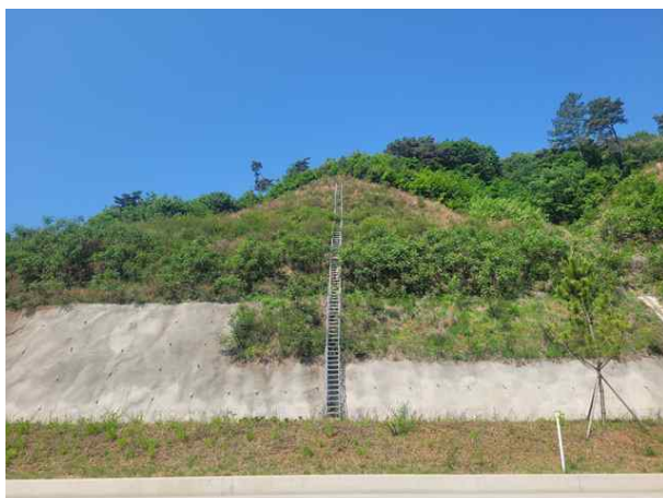
쏫크리트, 계단식옹벽 전경
