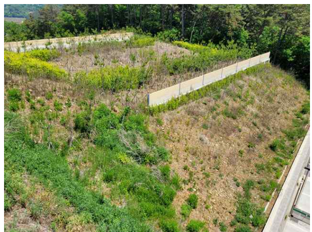
생태터널 상부 전경
