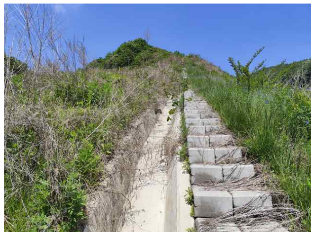
산마루측구, 점검계단 전경
