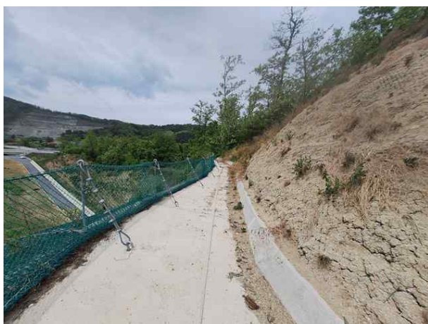
소단 배수로 전경
