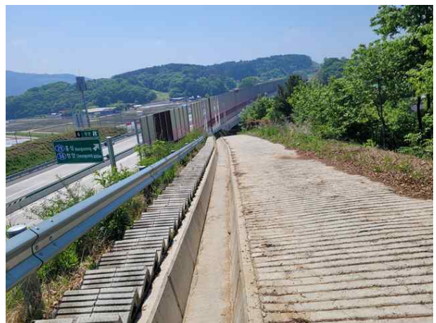
산마루측구, 점검계단 전경
