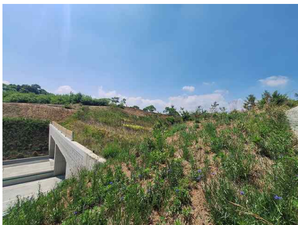
생태터널 상부 전경
