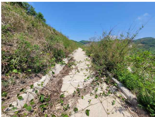
소단 배수로 전경
