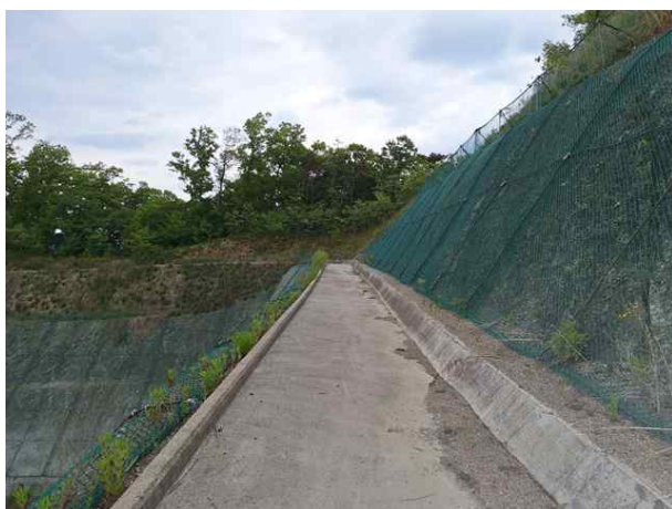
소단 배수로 전경
