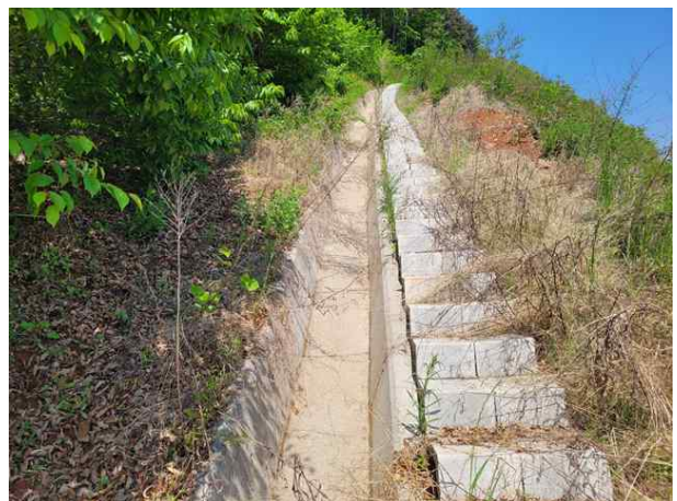
산마루측구, 점검계단 전경
