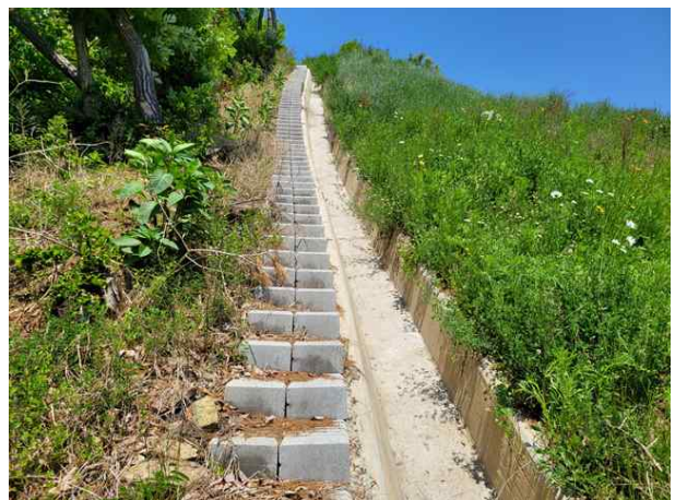
산마루측구, 점검계단 전경
