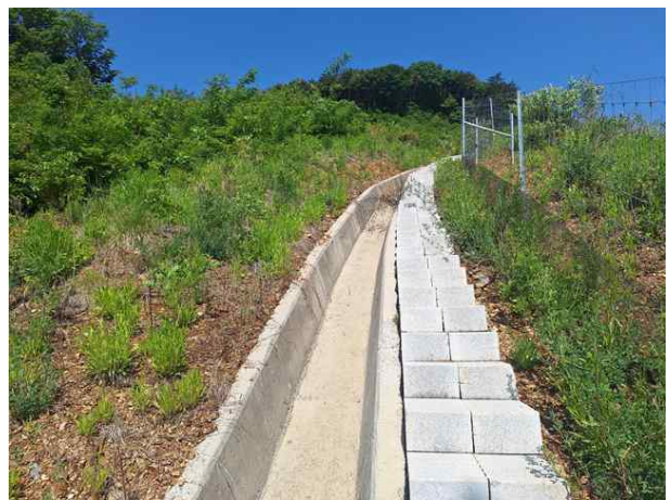
산마루측구, 점검계단 전경
