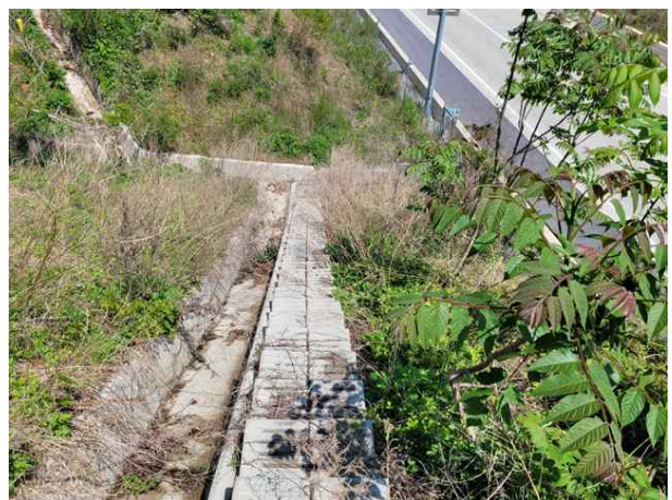
상부 사면 점검시설
