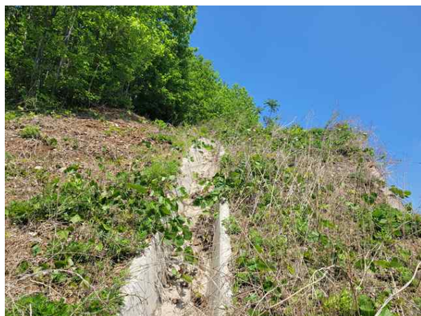
상부 사면 배수시설
