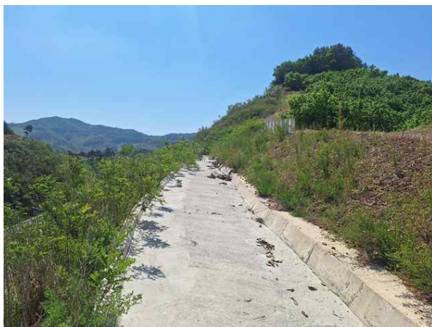
소단 배수로 전경
