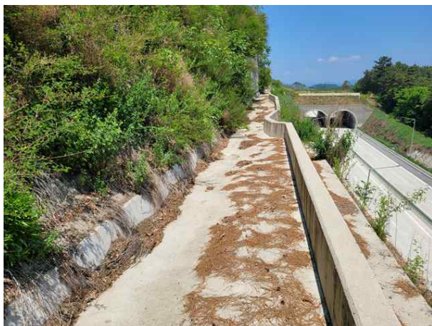
소단 배수로 전경
