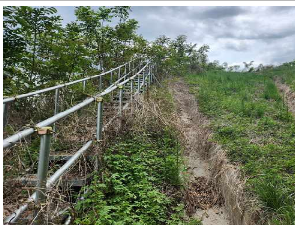
산마루측구, 점검계단 전경
