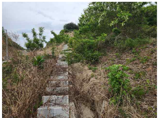
산마루측구, 점검계단 전경
