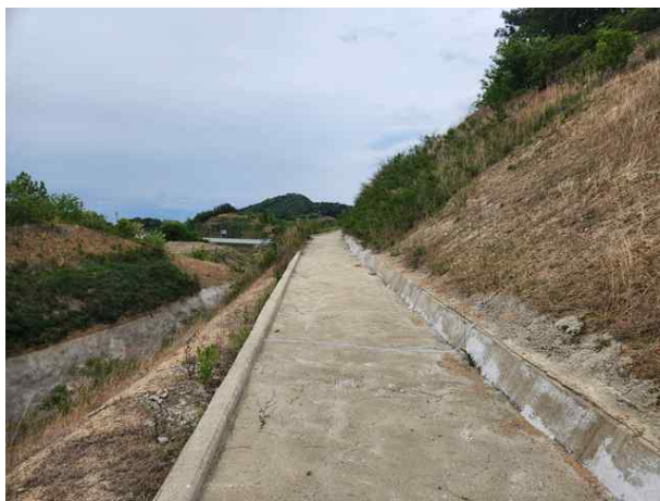
소단 배수로 전경
