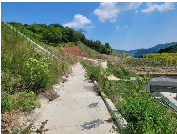
소단 배수로 전경
