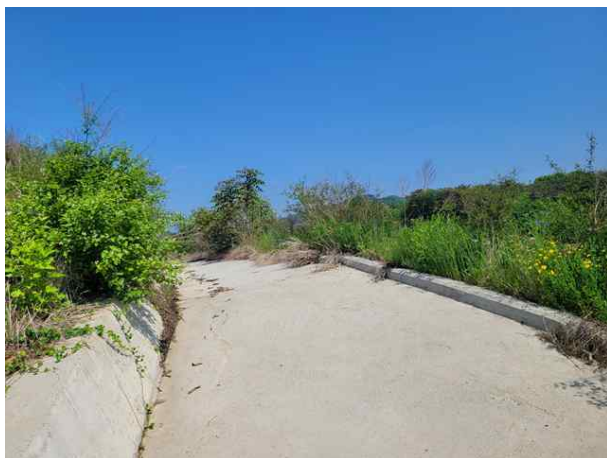
소단 배수로 전경
