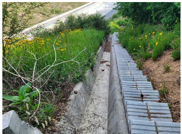
점검계단, 산마루측구 전경
